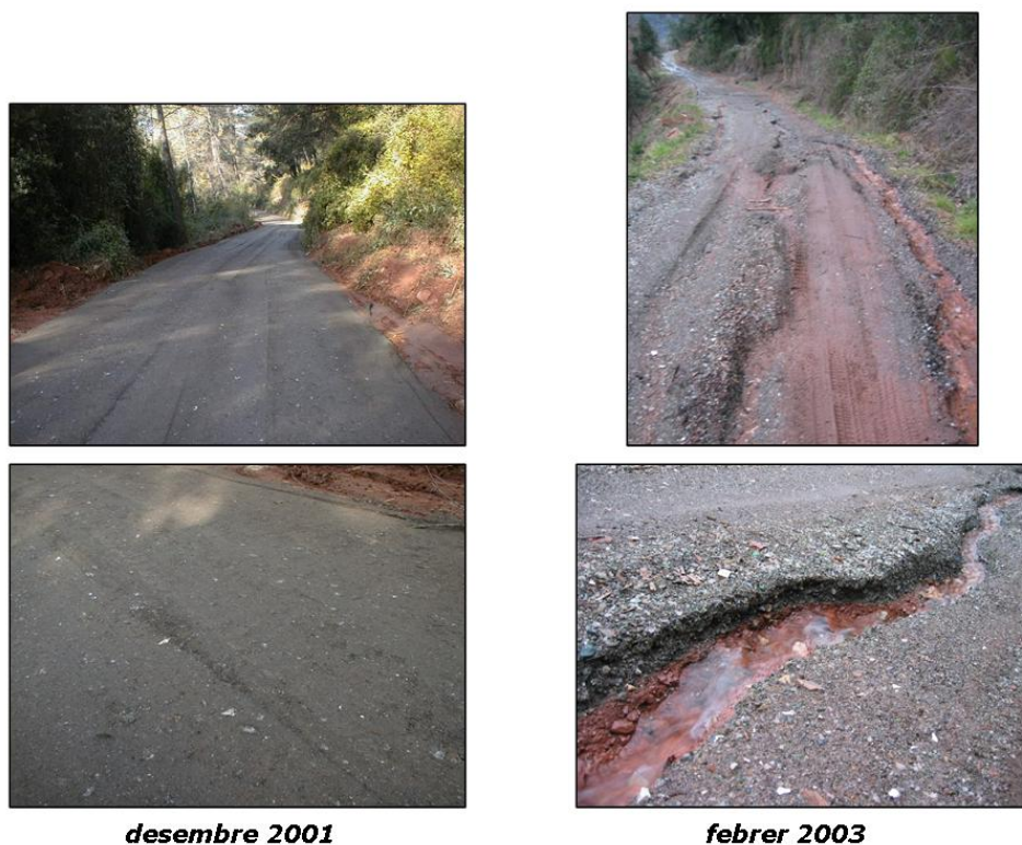
Figura VII-1. Evolució del tram de camí amb el rebuig d'escòries: visions generals i de detall. Aspecte del tram d'escòries una setmana després de l'execució de l'obra el desembre del 2001 (esquerra) i estat del mateix camí el febrer del 2003.
