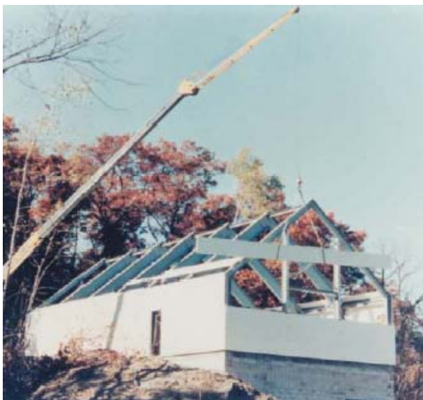
Figura 8.1. Detalle de colocación de panel de material compuesto con núcleo de poliuretano
