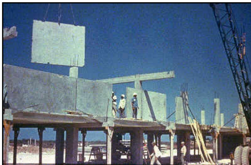
Figura 2.5: Sistema a base de paneles medianos
