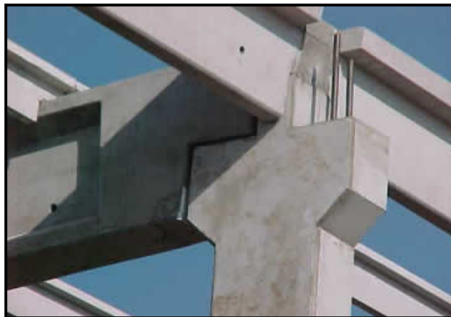
Figura 2.2: Montaje de elementos prefabricados.
