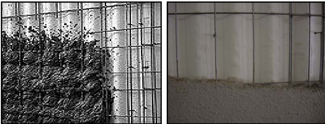
Figura 2.7: Proyección del mortero sobre el panel
