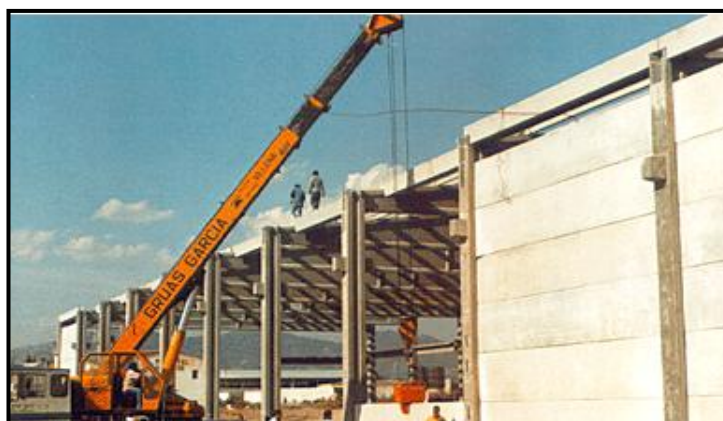
Figura 2.1: Montaje de elementos prefabricados
