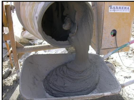
*Figura 4.13: Mezcladora manual utilizada para la preparación de la mezcla de mortero.*
