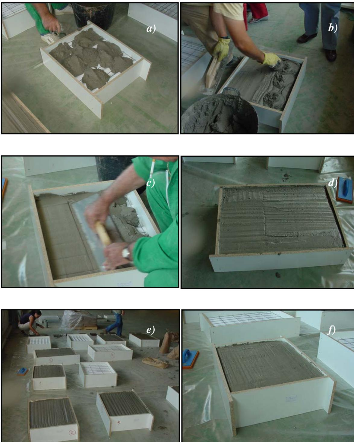
*Figura 4.3: Etapas de vertido y extendido del mortero en los diferentes paneles*
