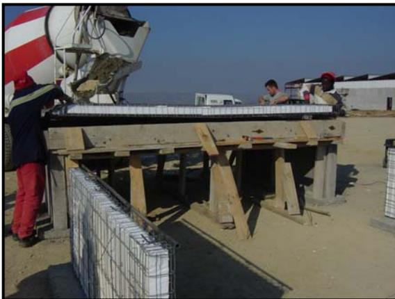
*Figura 6.9: Colocación del panel de la losa*
