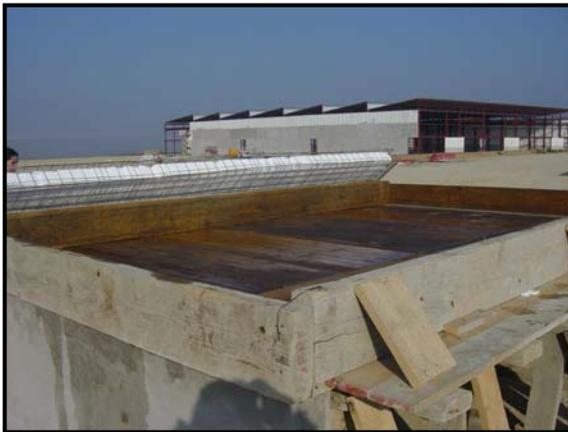
*Figura 6.7: Encofrado losa*
