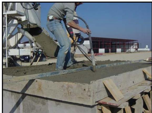
*Figura 6.10: Hormigonado losa superior*
