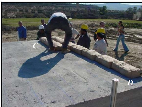
Figura 6.13: Marcas para colocación de sacos
