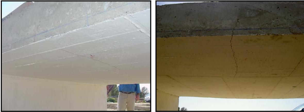
*Figura 6.26: Vista inferior y frontal de la 1ª fisura y propagación por el canto de la losa*
