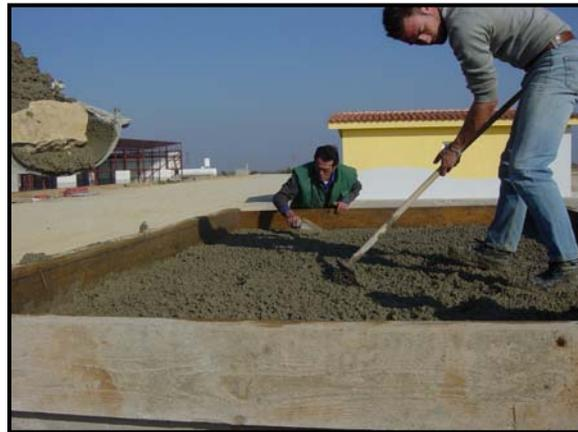
*Figura 6.8: Hormigonado losa inferior*
