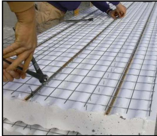
Figura 8.12: Armadura inferior del forjado
