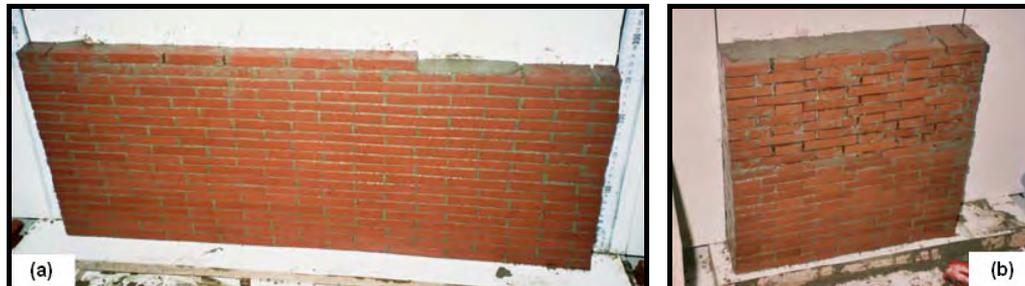
Figura 4. 5 [Momento en el que se lleva a cabo la construcción del aparejo simple (a) y el aparejo flamenco (b) sobre la mesa especial]
