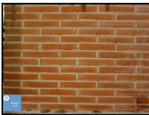
**a) Deslizamiento de Juntas 3V2H**
