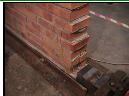
Alta densidad de fisuración
