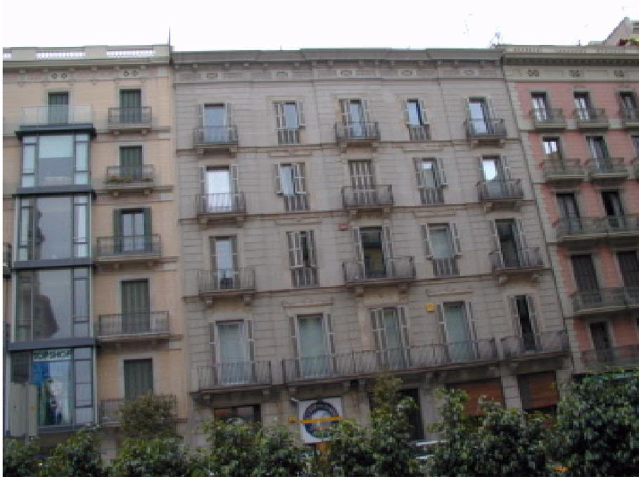
**Figura 11.4.** Fachada del edificio de 6 niveles de mampostería no reforzada, que ha sido modelado.
