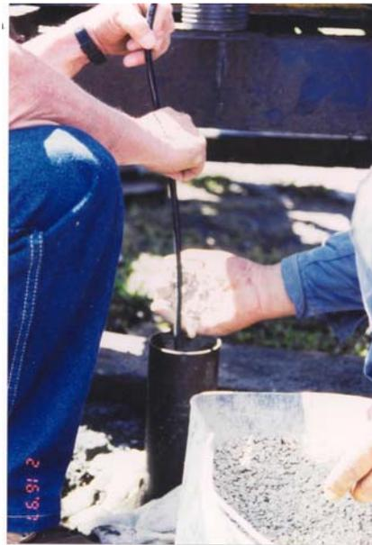
Figura 7.25: Protección piezómetro con material granular
