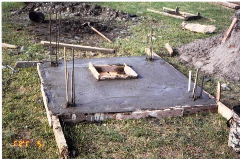
Figura 7.14: Construcción de la cimentación de la caseta
