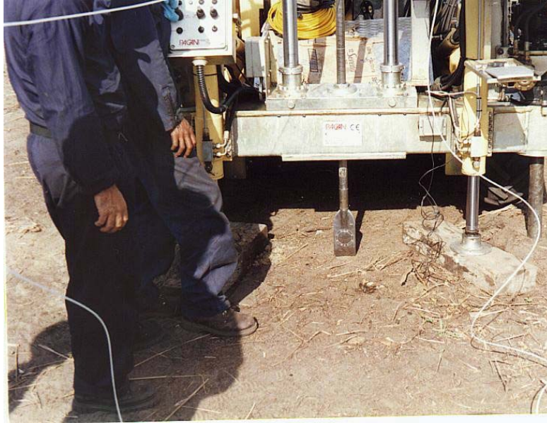
Figura 8.29: Dispositivo utilizado para la hinca del DMT.
