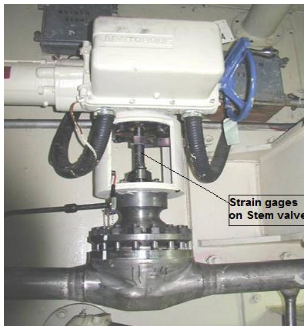
Figure 8: Posición montaje galgas extensiométricas en eje
