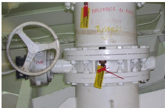
Figure 21 : Válvula mariposa con actuador eléctrico Hispania Spirit
