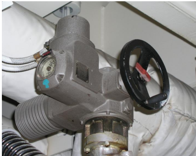
Figure 20 : Actuador eléctrico de válvula mariposa Catalunya Spirit
