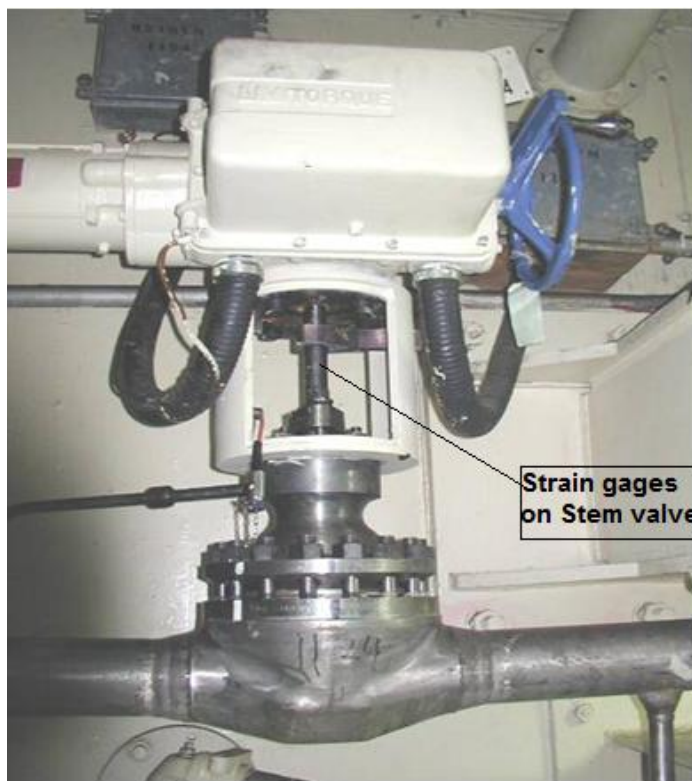
Figure 17: Posición montaje galgas extensiométricas en eje
