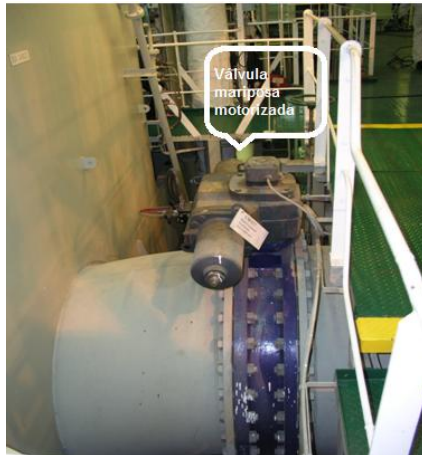
Figure 18: Válvula mariposa motorizada. Hispania Spirit
