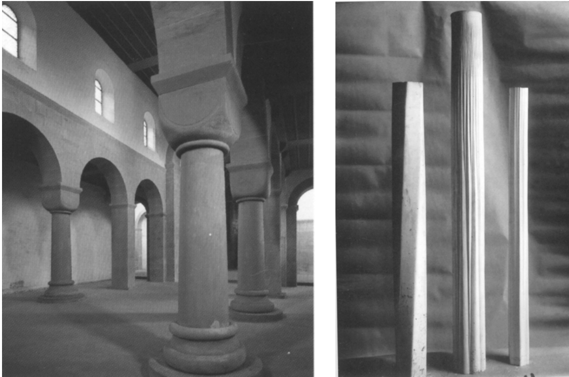
Capiteles de las columnas de San Egidio en Kleinkomburg y Modelos de estudio en yeso de las columnas para la Sagrada Familia de A. Gaudí.
