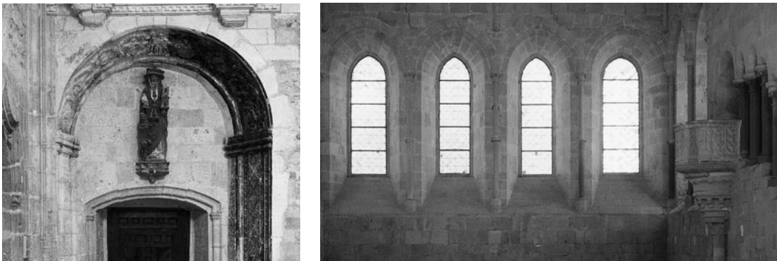
Dos soluciones de capialzado en una misma puerta de Santa Maria de El Parral en Segovia y cuatro ventanas que resuelven la transición entre las dos aberturas de maneras distintas en la cabecera del refectorio de Santa Maria de Huerta en Soria.
