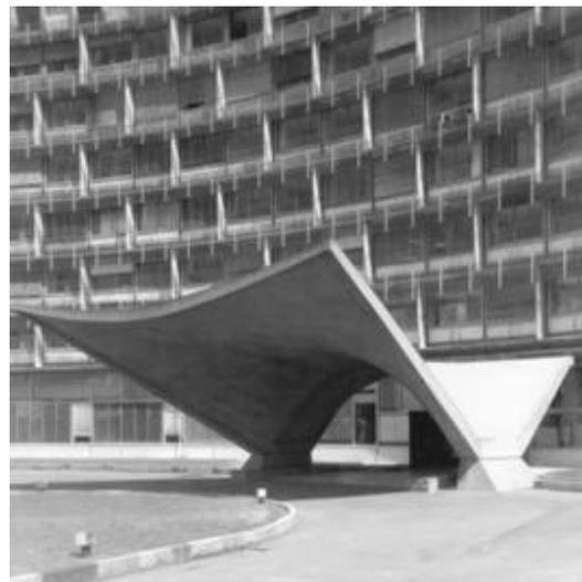
La estación de Tren de la ciudad de Savona, de Nervi, presenta unos pilares formados por la transición entre dos secciones distintas: dos rectángulos dispuestos en dos direcciones ortogonales.
