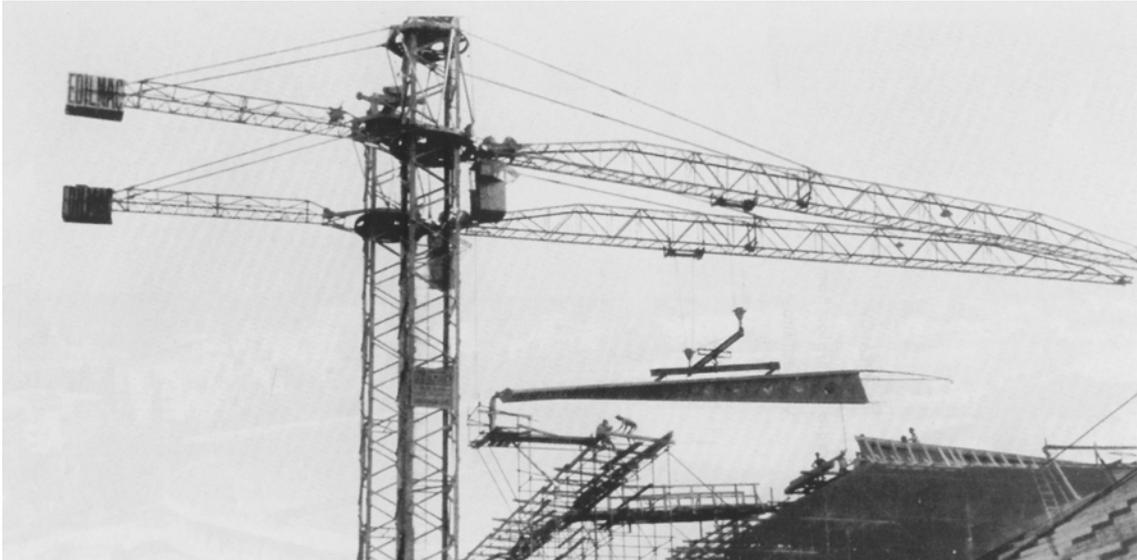
Momento de la colocación de las piezas prefabricadas en su lugar. Mientras se montan los encofrados de la parte trasera para proceder al vertido del hormigón y crear una cubierta unitaria.
