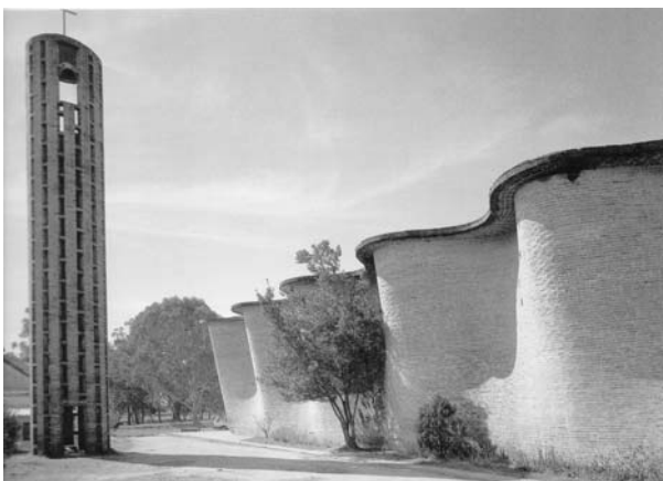
Vista del campanario exento.
