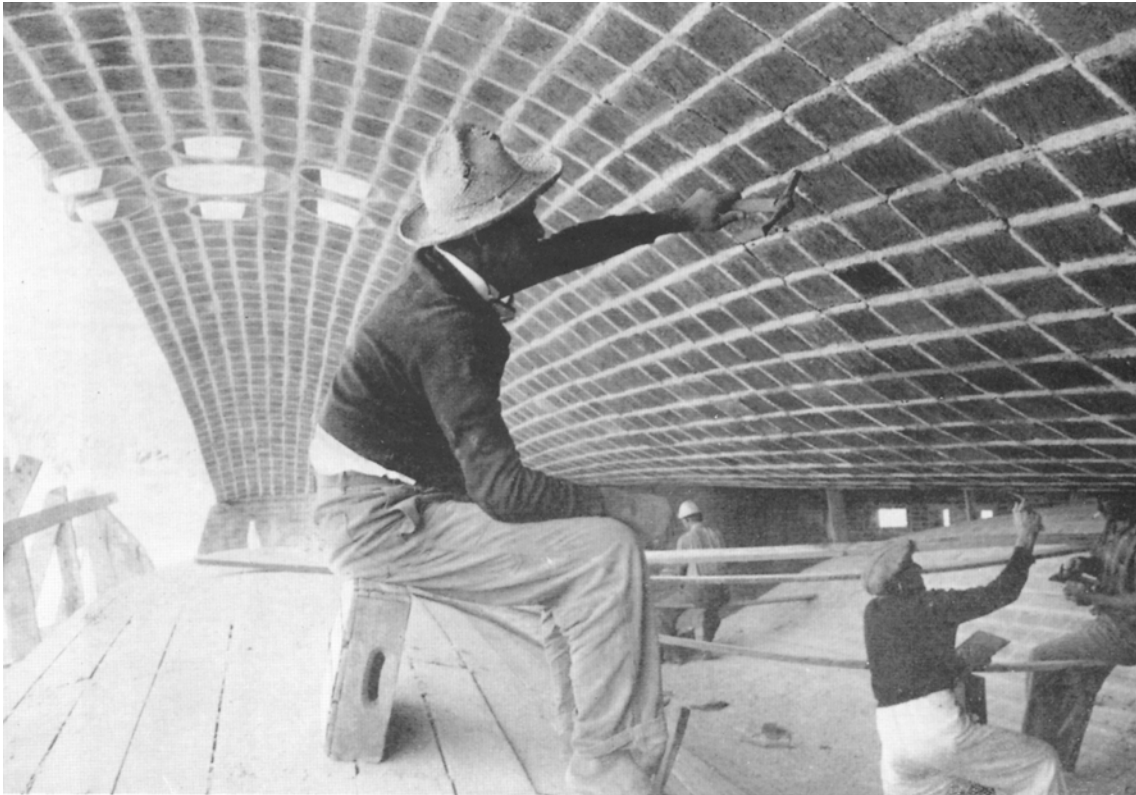
El encofrado sirve de andamio para los retoques del techo.
