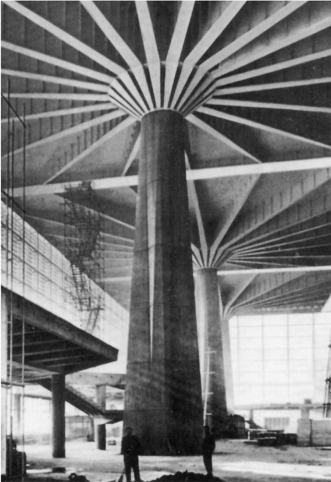
La estructura de la cubierta es independiente de los forjados de la galería perimetral.
