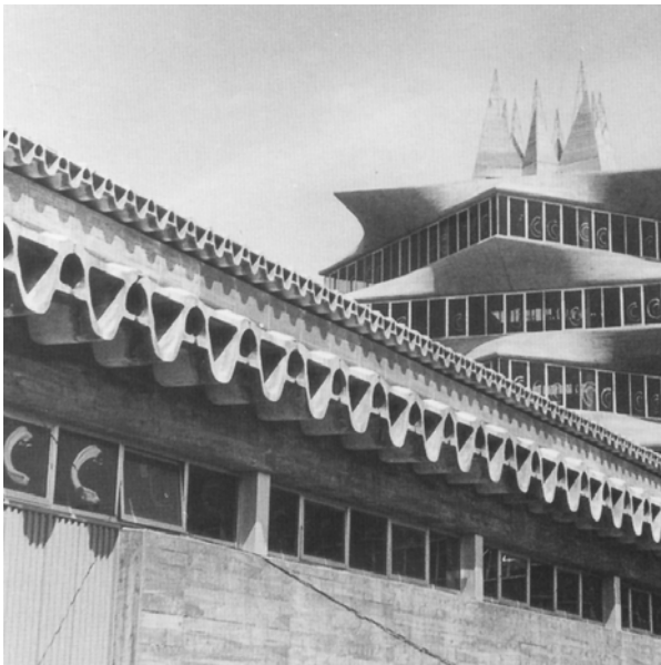
Las cabezas de viga, que sobresalían, formaban el alero y reproducían en él la sección de las naves. Formada por la losa alveolada.
