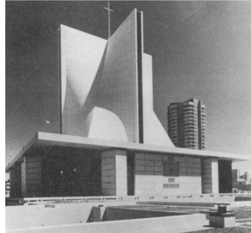
Interior de la cubierta donde se ve el despiece triangular que lo conforma y exterior donde se ve el despiece del recubrimiento de mármol que debe ajustarse a las líneas rectas de la forma de la superficie.
