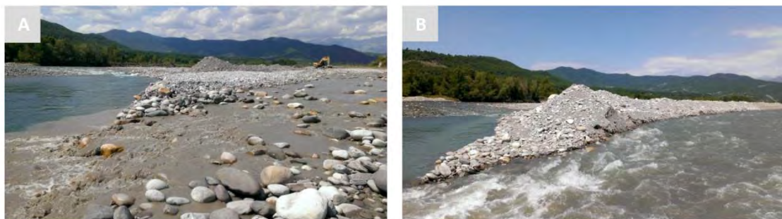
Figura 3. Fotografías durante los trabajos de adecuación previos a la actuación en el cauce (extracción de áridos) en un tramo del alto Cinca en agosto de 2014. (A) Pluma de sedimento en suspensión durante la creación del cauce alternativo el día 6 de agosto, corresponde a la máxima concentración registrada. (B) Detalle de la erosión lateral durante la apertura del cauce alternativo el día 18 de agosto.
