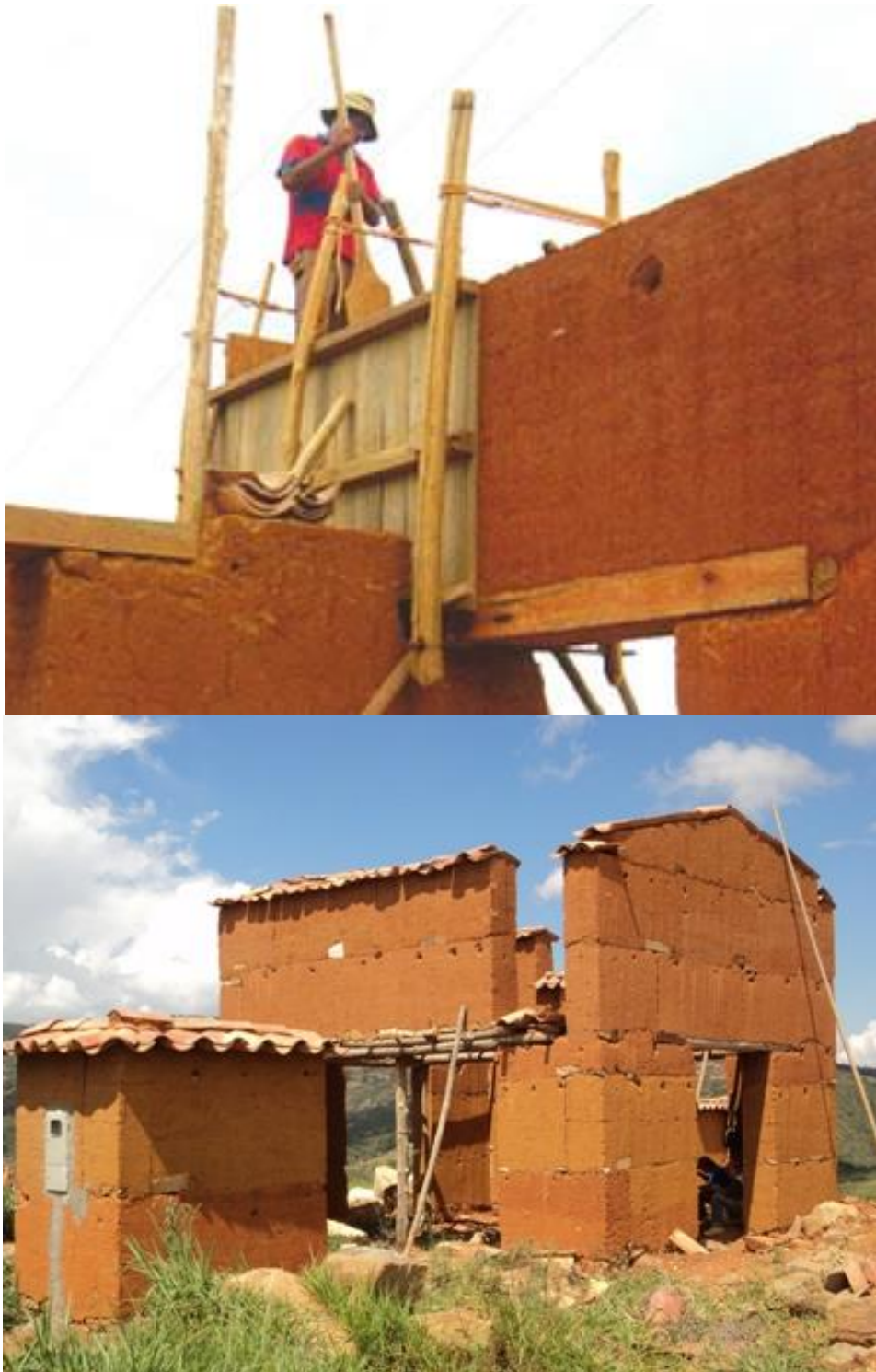
Figuras 28 y 29. Construcción en tapia pisada.
