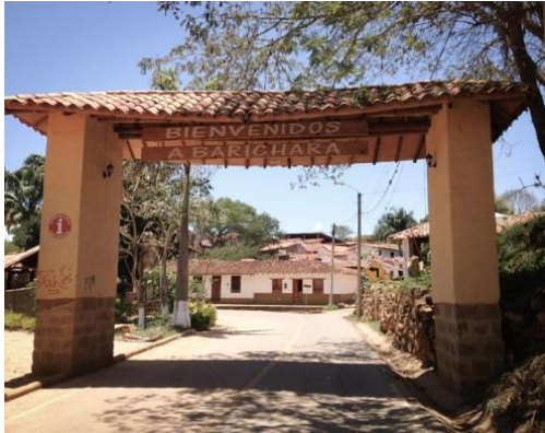
Figura 20. Portal de entrada al casco urbano de Barichara.
