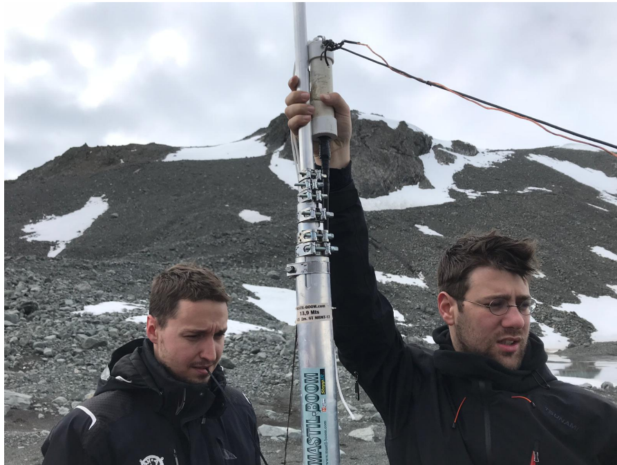
Figura 14: Instalación antena en Nodo Caleta Argentina. Nodo situado a 1km de la base [2]
