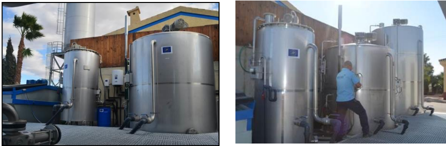
Figura 127: Digestores anaerobios utilizados en la planta piloto STO3RE.
