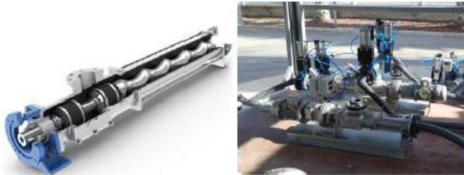
Figura 130: Bombas de lodos utilizadas para trasegar el lodo entre las diferentes etapas de la planta piloto.
