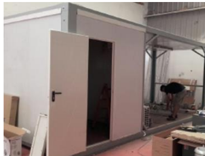
Figura 126: Cabina portátil donde se encuentra la instalación de la planta piloto STO3RE.
