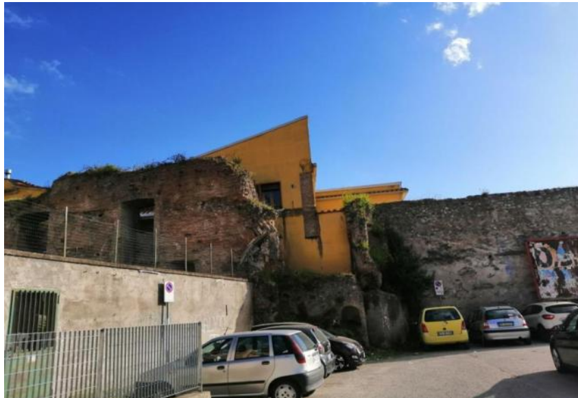
Fig. 15: Ruderì del monastero di San Pietro e tratto di mura della città 608 .
