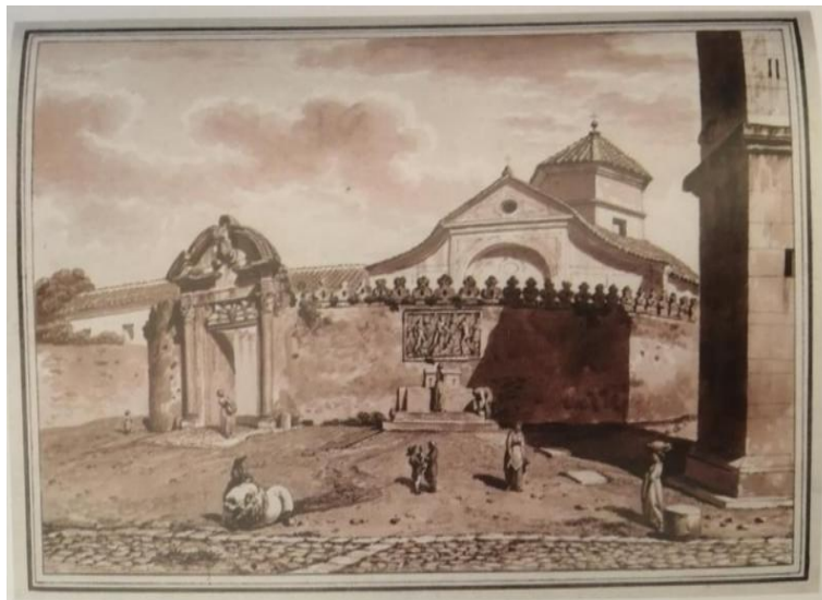
Fig. 38: Il muro di cinta 1863 .
