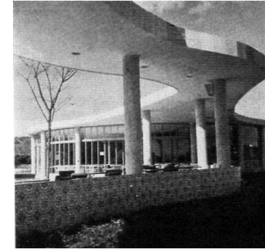
1.43. Casa del Baile. Detalle del paseo cubierto de acceso en hormigón.
