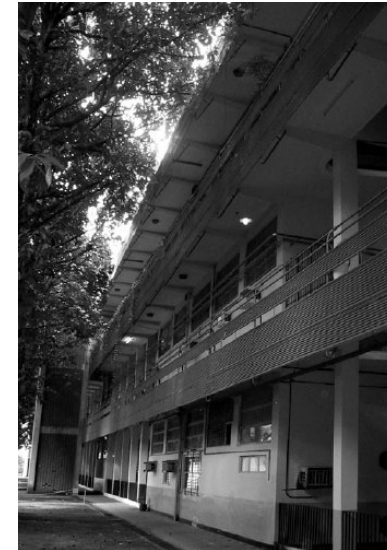
4.1.14.Detalle de la fachada oeste de la Facultad de Medicina: brises metálicos.
