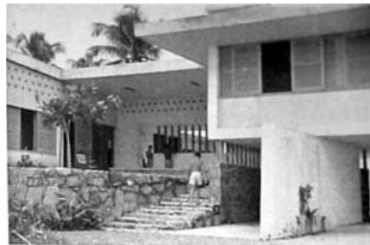
4.1.39.Fachada Este de la Casa Couceiro:detalle
