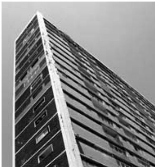
4.2.44.Cerramientos del Edificio Caetés.1955.Celosias cerámicas:combogós.
