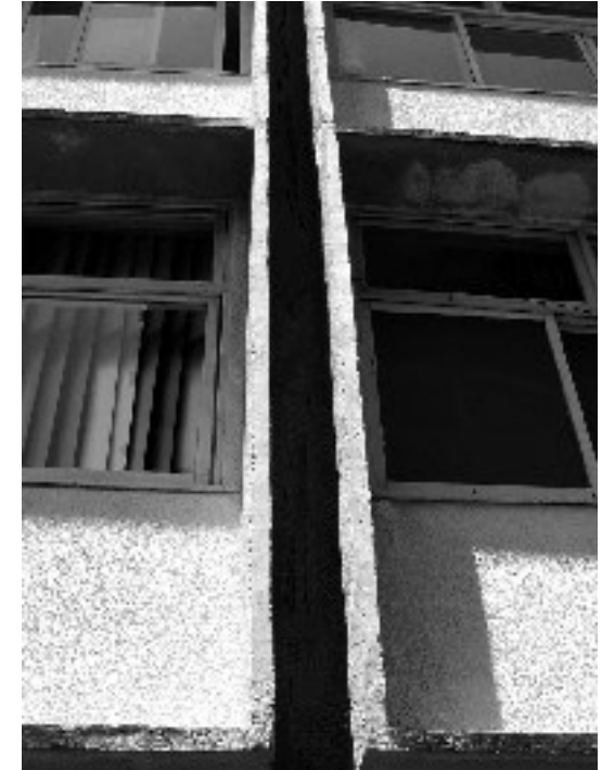
4.2.41. Detalle fachada: ED. União. 1953.
