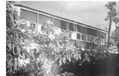
4.2.9. Casa A. Freitas. João Pessoa. Paraíba. 1958.
