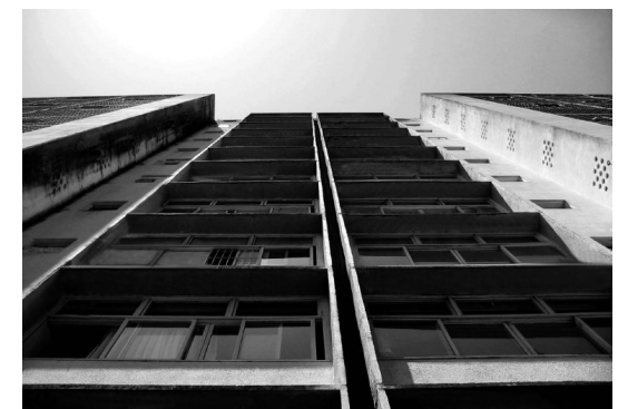
4.2.42. Detalle fachada: ED. União. 1953.
