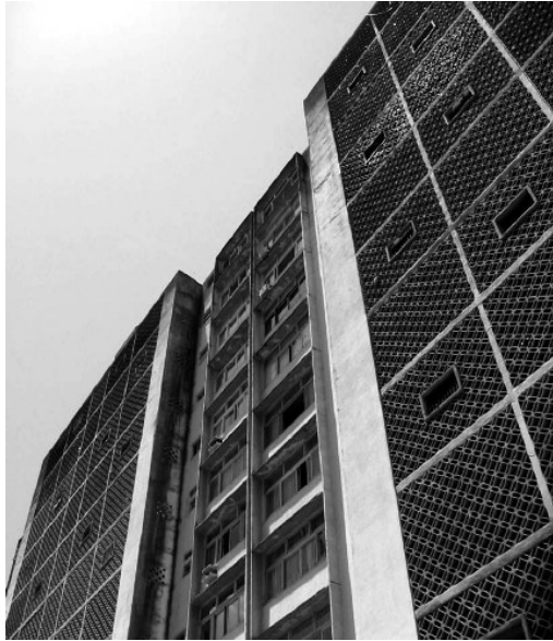
4.2.43.Cerramientos del Edificio União.1953. Celosias cerámicas:combogós.
