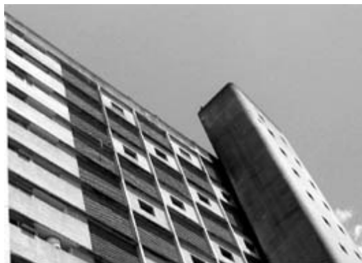
6.55. Edifício Walfrido Antunes. Valdeci Pinto. 1958.
