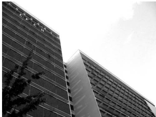
6.54. Edifício del CEFICH. Mellia. Años 50.
