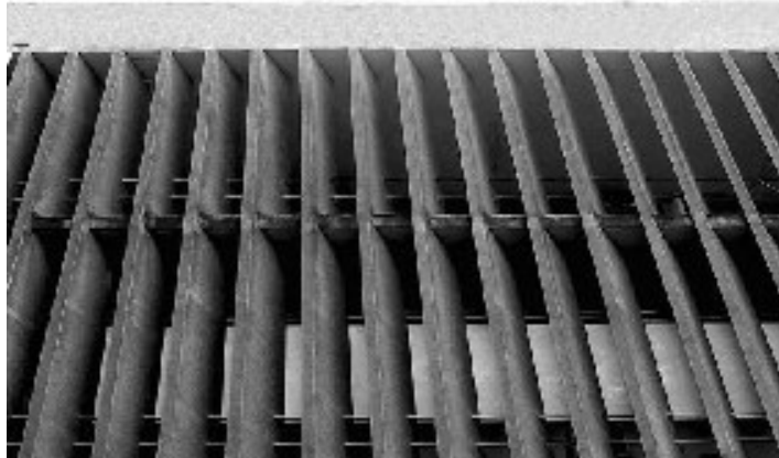
6.43. Detalle brises: Instituto de Antibióticos.Russo.1953.Fachada poniente
