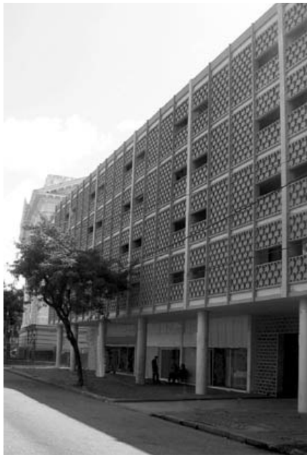
6.57. Edificio Santo Antonio. Borsoi. 1963. Detalle de las celosías en cemento.
