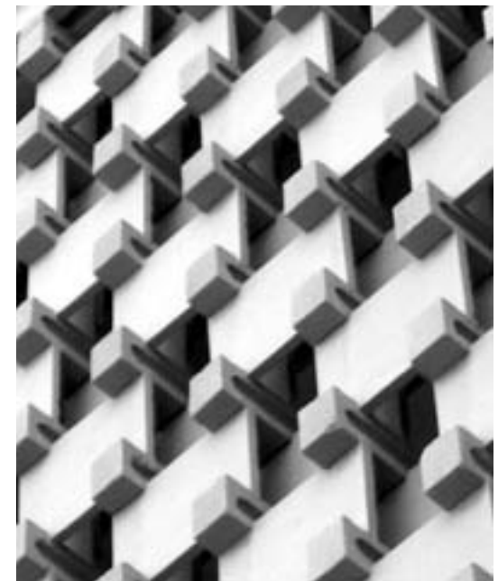
6.58. Edificio Santo Antonio. Borsoi. 1963. Proyecto en el cual el arquitecto desarrolló un diseño exclusivo para las celosías en cemento.
