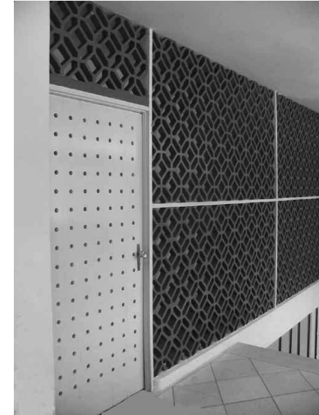
6.42. Casa G. Raposo. Amorim. Observar el tratamiento dado a la pared, con celosías cerámicas y puerta vaciada, creando un gran paño que posibilitó la circulación constante del aire.
