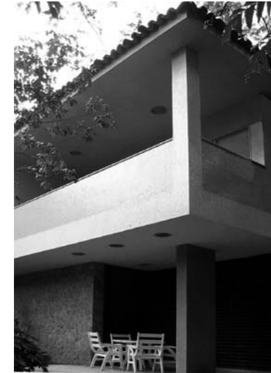
76. Detalle de la fachada principal.
