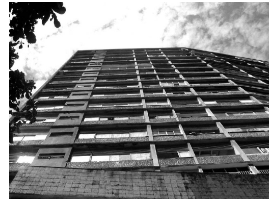
A.4.2.116. Detalle de la fachada Sur.
