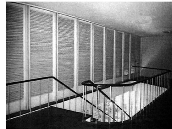
84. Detalle de panel de cerramientos.
