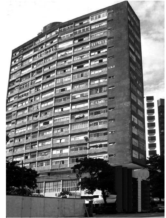
107. Fachada Sur y Este.
