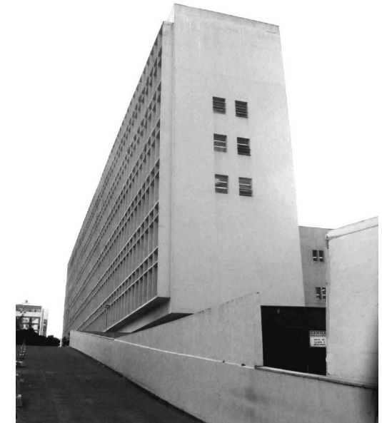
135. Fachada Principal o Este del Hospital de Pronto Socorro.
