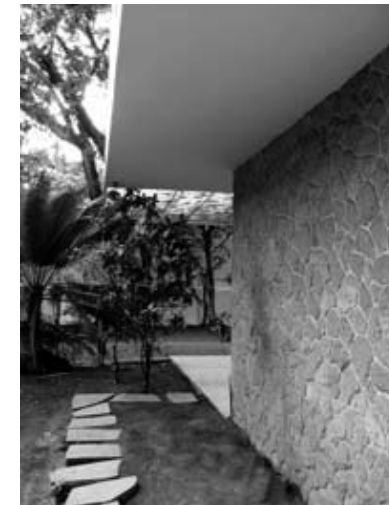
77. Detalle de la fachada principal.
