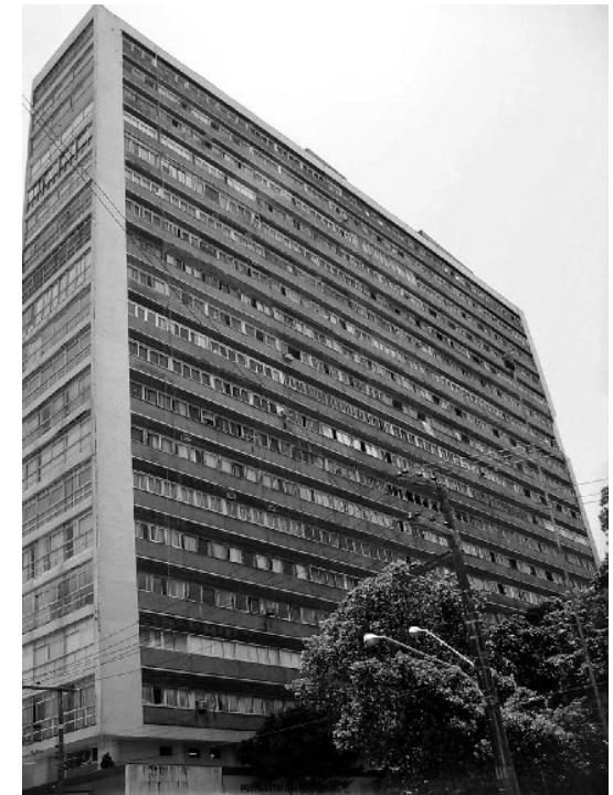
A.4.2.117. Detalle de la fachada Nordeste.
