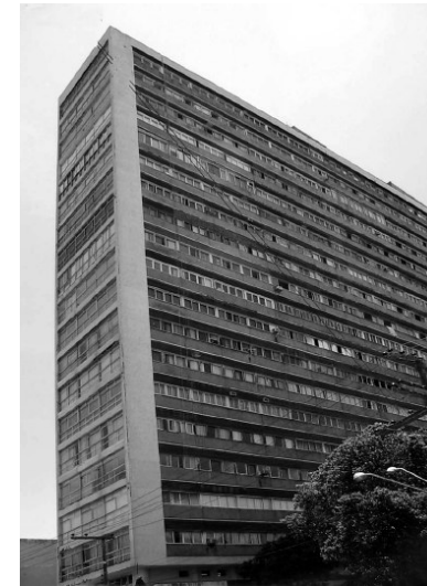
131. Detalle de la Fachada Nordeste.
