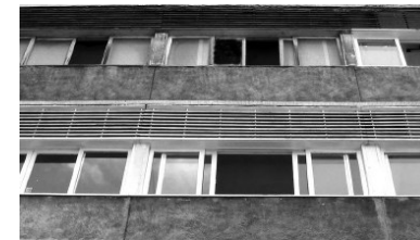
132. Cerramientos de la Fachada Nordeste.
