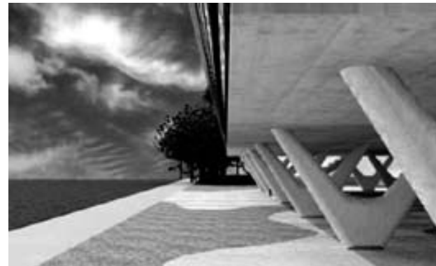
146. Detalle de los pilares de la planta baja
