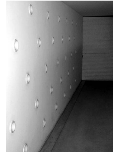
17. Paredes con buzinotes: rampa de acceso a la planta alta.
