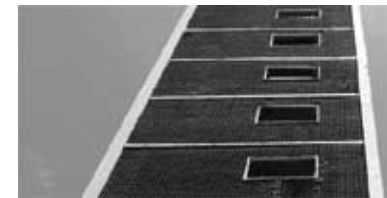
127. detalle de la fachada noroeste.
