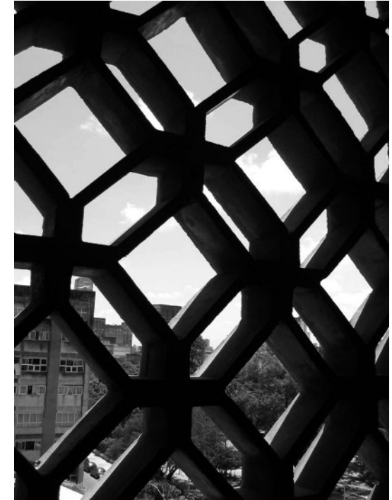
94. Detalle de los combogós.
