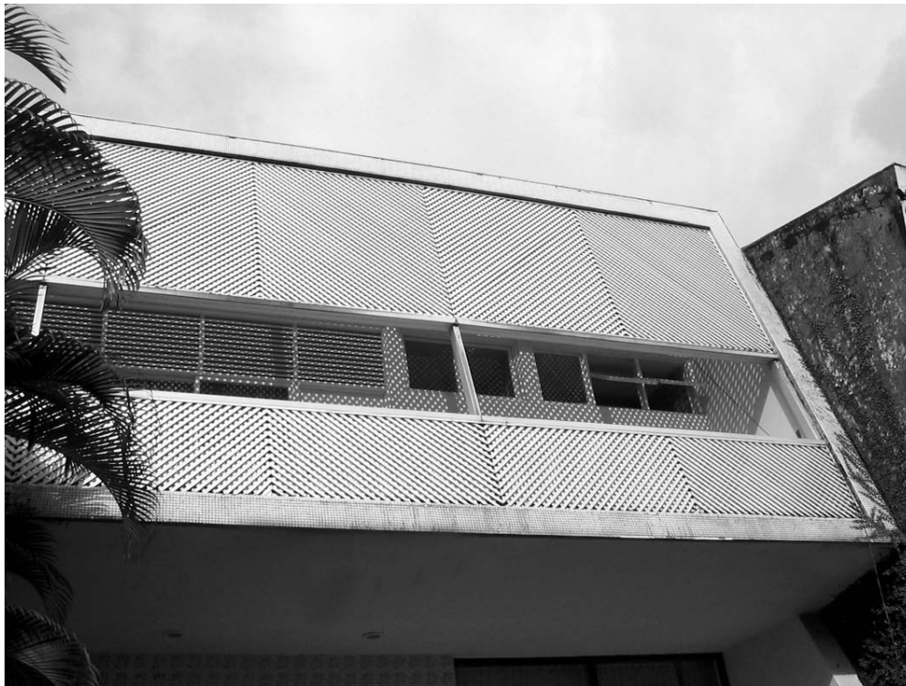
4.Detalle de la fachada principal.
