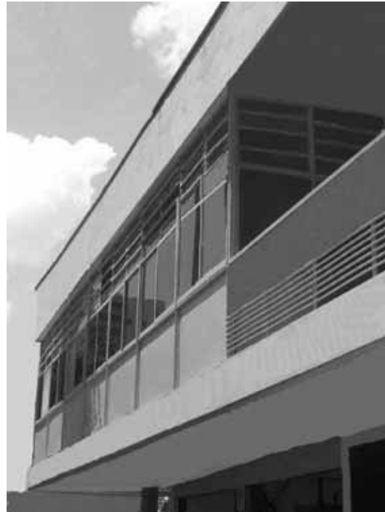
A.4.3.8.Fachada Este o principal:detalle.
