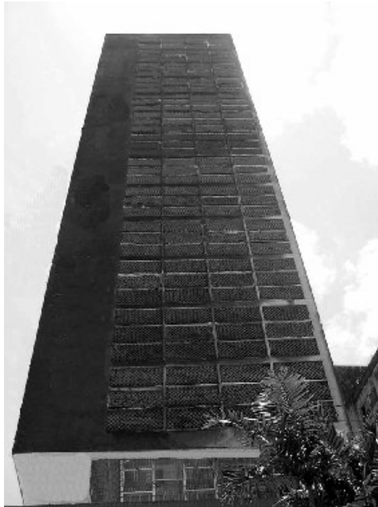
A.4.3.77.Fachada Este: detalles con cerramientos en combogós cerámicos.Observar la influencia de los edificios del Parque Guinle,de L.Costa.
