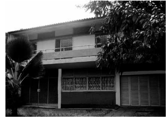
A.4.3.51. Fachada principal.
