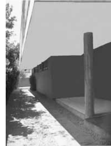
A.4.3.9. Detalle estructura.
