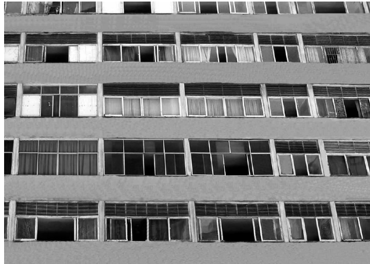
A.4.3.75.Fachada Norte:detalles de los cerramientos.
