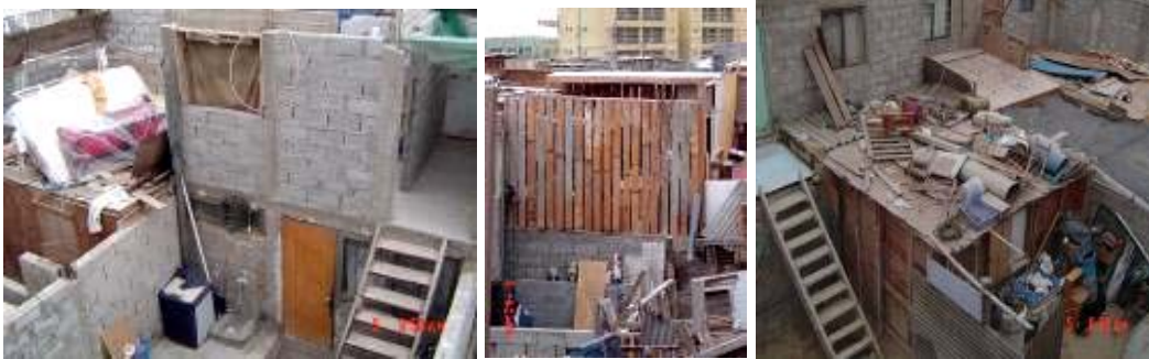
Ilustración 38: izquierda, viviendas aledañas, se encuentran en estado de transformación. [2004]. 78
