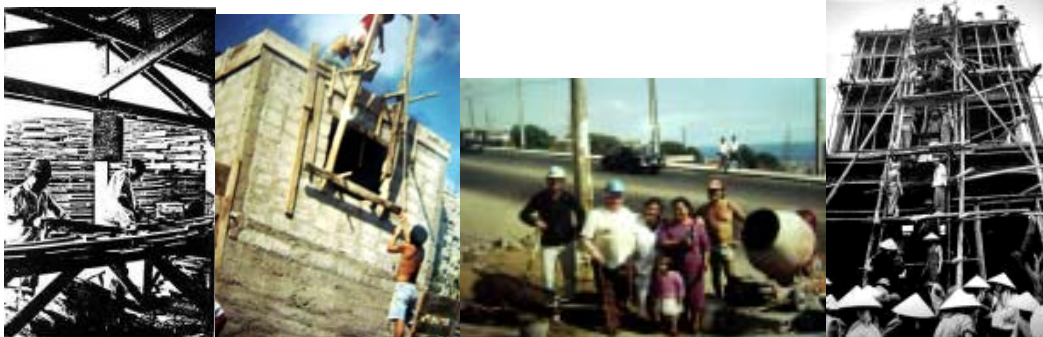
Ilustración 24: Izquierda, Autoconstrucción: "EL CORTIJO", taller de obras, Chile. 61
