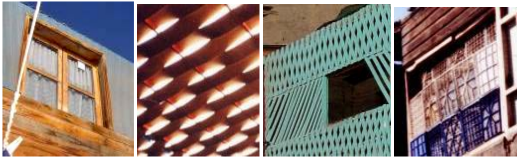
Ilustración 1: Izquierda, vivienda construida con materiales de recuperación, mallas de polietileno. 9
