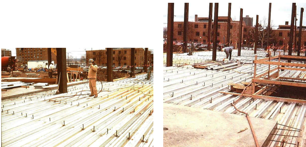
Figura 1-1 Losas mixtas en construcción
