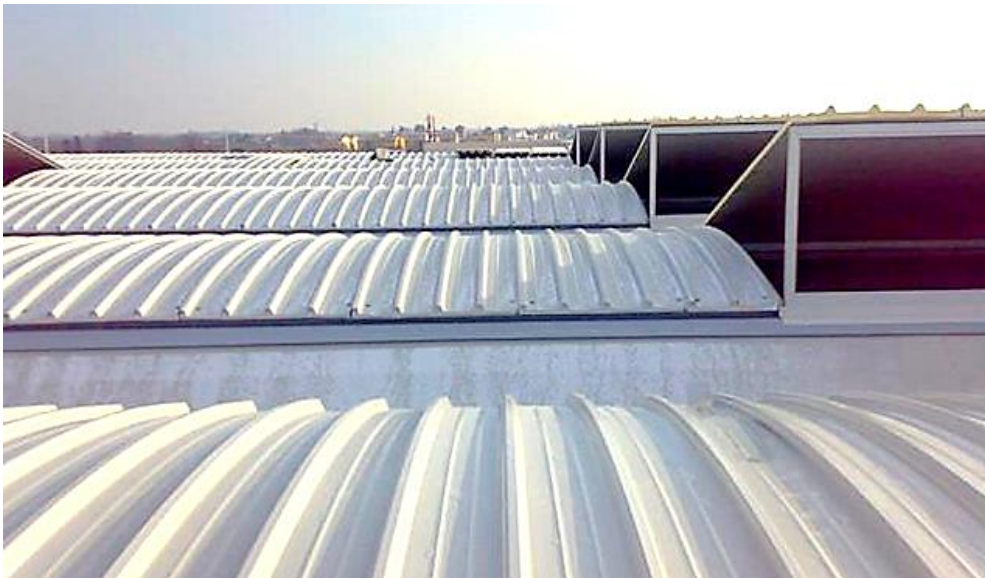
Fig.2. Imagen de cubierta construida con perfiles curvos
