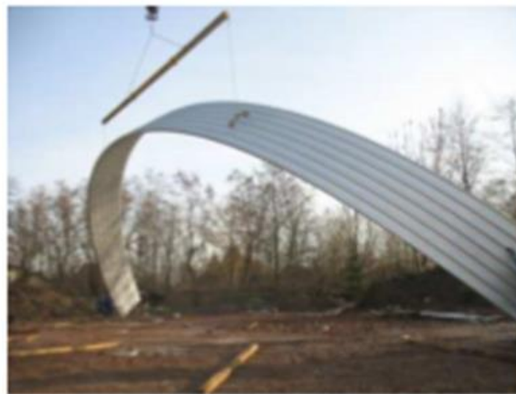
Figura d. Método de colocación de los arcos.
