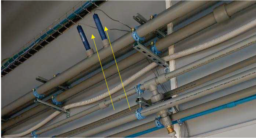
Figura 6.8: Dispositivos de ORP y pH en Circuito 1, respectivamente
