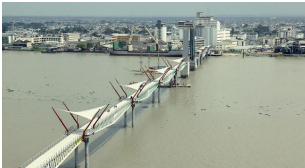
Ilustración 31- Puente basculante de Isla Santay- sector de Durán. Fuente: https://djesgaro.files.wordpress.com/2016/02/screenshot_313.jpg
