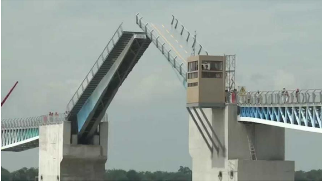
Ilustración 33- Puento Basculante para ingreso y salida de la Isla Santay. Fuente: https://i.ytimg.com/vi/BIIBDSC-MOO/maxresdefault.jpg
