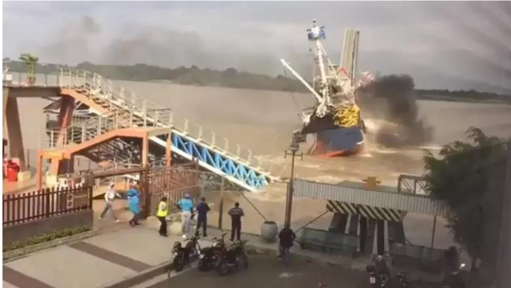
Ilustración 35- Daño causado por una barcaza al chocar con el puente de la Isla Santay- 2017. Fuente: https://media.diariolasamericas.com/p/3b818a8cb33c87b89802bb4efe508013/adjuntos/216/imagenes/001/182/0001182225/barco-choca-puente-guayaquil-ecuador-twitterjpg.jpg
