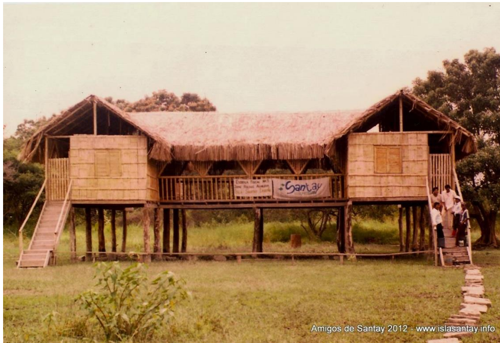
Ilustración 8- Casa Comunal y Escuela de la Isla Santay año 1999. Fuente: Amigos de Santay https://1.bp.blogspot.com/-iVyd_LxLlOY/U4xY2F9eAaI/AAAAAAAAAUoU/2SqEz52d1o0/s1600/nuevecita.jpg
