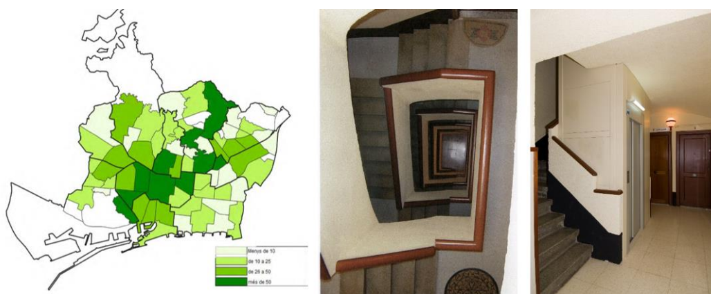
Figura 68-69. Mapa actuaciones en accesibilidad por barrios (2010-2018); fotografías del antes y después de la instalación de un nuevo ascensor en hueco de escalera de un edificio de 4 viviendas por rellano.
