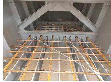
(d) Reinforcement of concrete bottom slab
