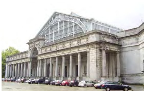
Vista exterior del museo. Fuente: Autoworld Cinquantenaire , de Ben2, 2006, Wikimedia Commons ( https://commons.wikimedia.org/wiki/File:Autoworld_Cinquantenaire.JPG ) CC BY-SA 3.0
