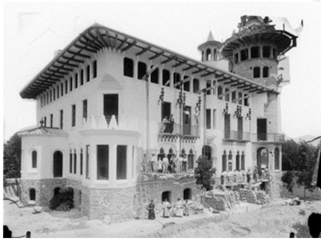
Figura 53: La Casa Pairal en pleno proceso de construcción (1900-1906). Fuente: Archivo Comarcal de l'Alt Penedès
