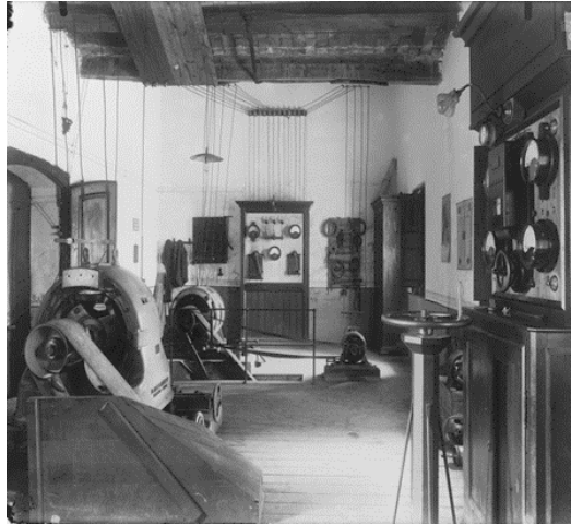
Figura 32: Sala de generadores y de control eléctrico de Can Codornú. Fuente: Archivo Comarcal de l'Alt Penedès.
