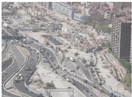
2,47 2,48 Proyecto Madrid-Río, recuperación del entorno del río Manzanares con el soterramiento de 6km de la autopista M30.
