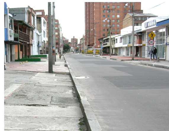
6,22 Aceras en transformación calle 80.
