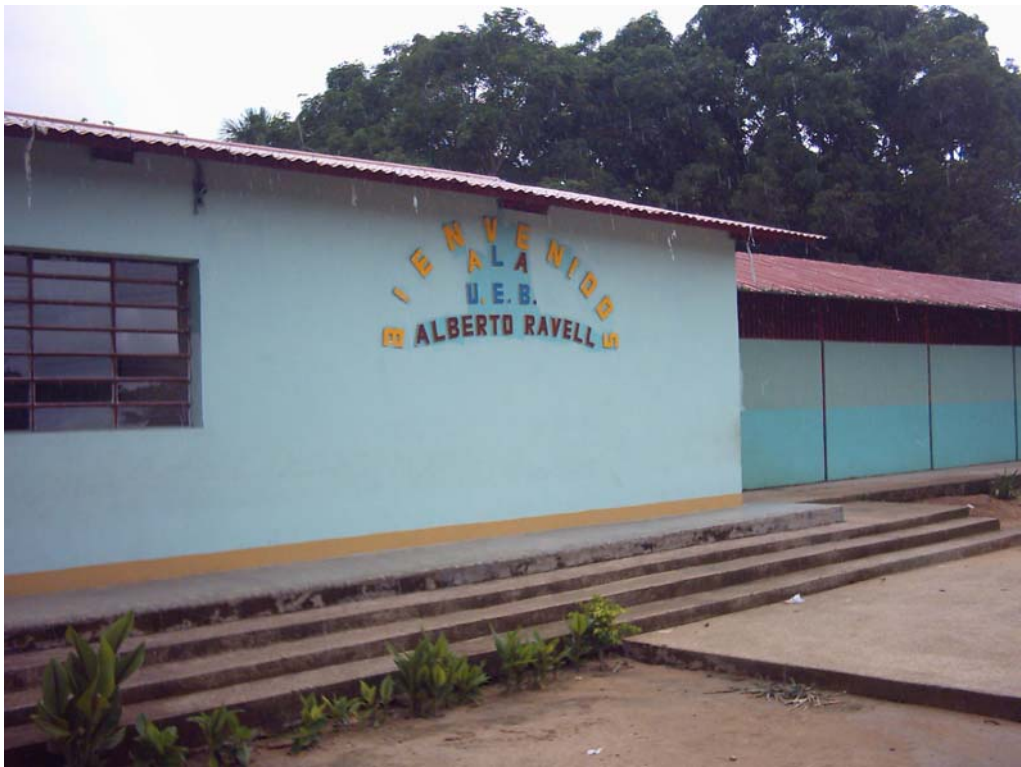
Fachada de la UEB «Alberto Ravell»
