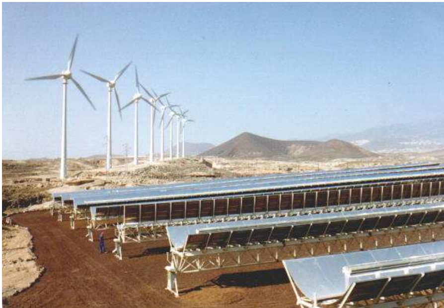
Figura 1.5. Planta solar EUCLIDES (concentradores cilindro parabólicos).
