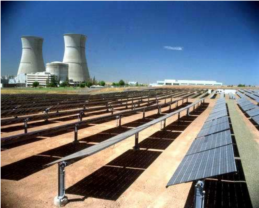
Figura 1.4. Sistema de 2-MW emplazado en Sacramento, California (fuente: DOE/NREL, Warren Gretz)
