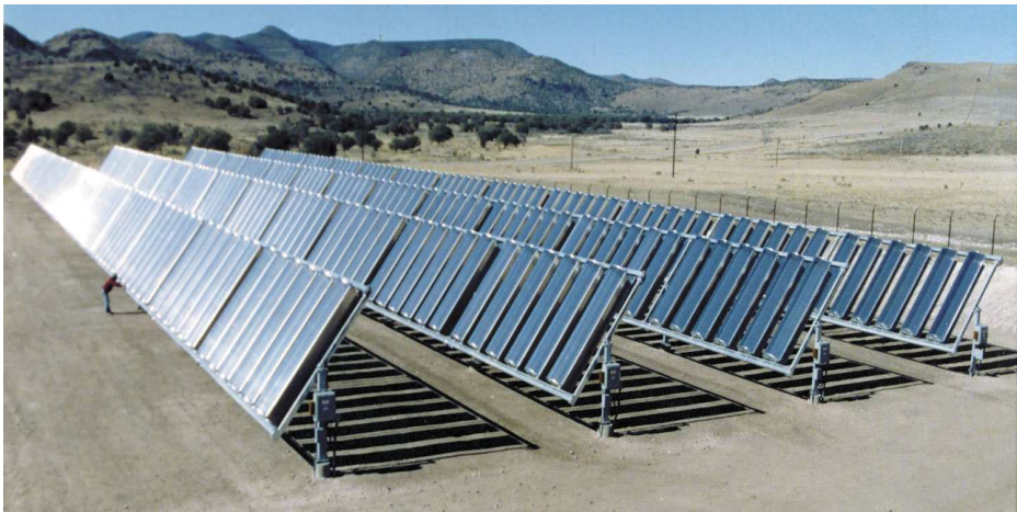
Figura 1.6. Planta fotovoltaica (concentrador constituido por lentes de Fresnel lineales arqueadas- Entech-). Fuente NASA.
