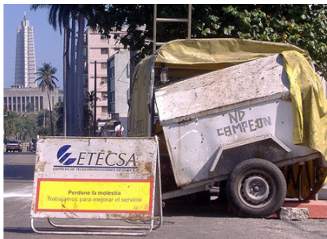
Imagen 5: Obras de ETECSA en la vía pública
