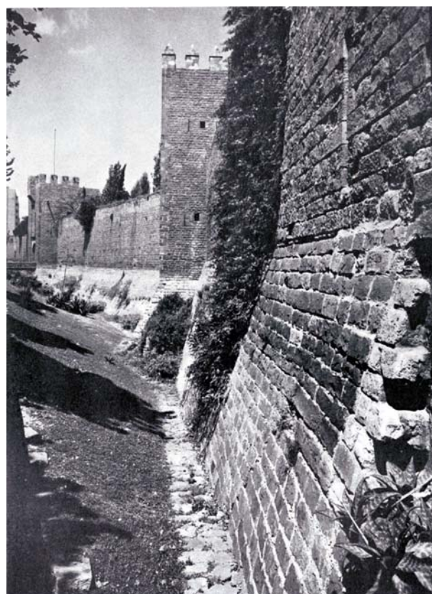
La muralla, la torre 6 (de ponent), la torre porta de Santa Madriona i el fosat (reconstruït per A. Florensa). Arxiu Museu Marítim de Barcelona).
