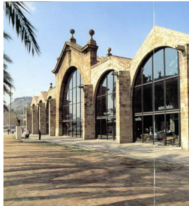
L'espai del porxo de la façana sud incorporat al gran cos de les naus (Arxiu Museu Marítim de Barcelona).
