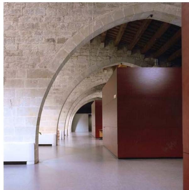
La planta alta de Porxo Nou restaurada amb els volums tancats independents de l'estructura (Foto Jordi Canosa).
