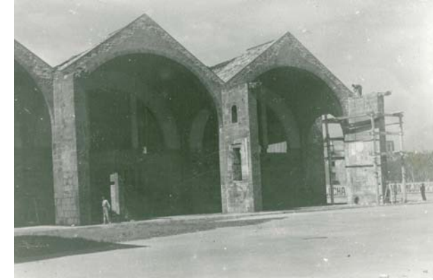
La façana sud de les naus de la Generalitat restaurada per Florensa amb contrafort de l'origen.
