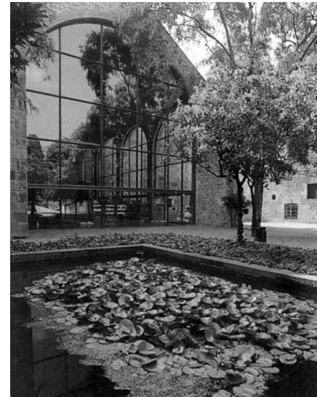
La façana nord de les naus de la Generalitat (la llotja de Sant Cristòfol) restaurades i tancades amb vidrieres al 1992 (Arxiu Museu Marítim de Barcelona).
