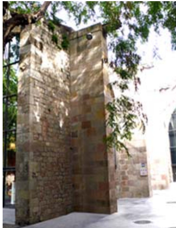
Els contraforts frontal i lateral de la llotja de Sant Cristòfol amb les gàrgoles disposades en sentit transversal a la canal de desguàs (Arxiu Terradas Arquitectes).
