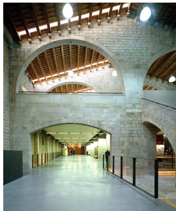
El vertical Galceran Marçet i les naus de l'edifici Porxo Nou on s'han restituit les primitives proporcions. Les baranes de dreta i esquerra assenyalen on es troba l'antic paviment, uns 50 cms per sota de l'actual (Foto Jordi Canosa).
