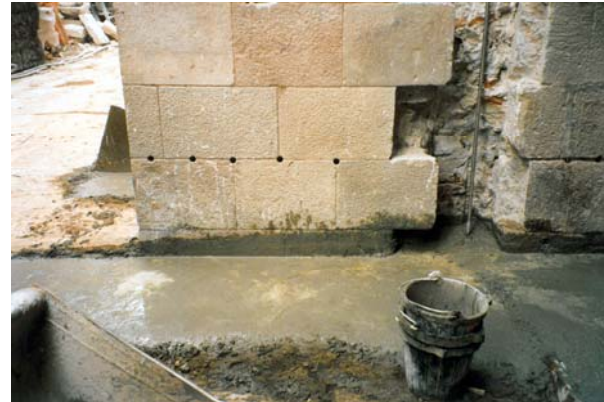
Substitució dels perfils metàl·lics que hi havien en els contraforts per barres d'acer inoxidable escastades en una base de formigó (Arxiu Terradas Arqtes.).
