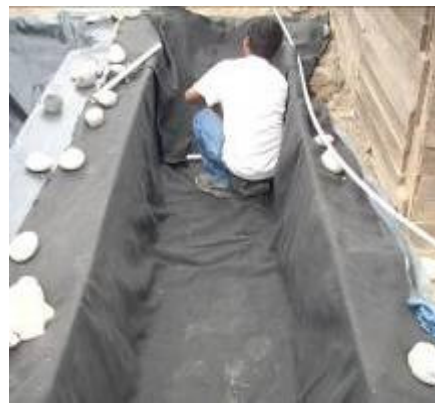
Foto 83 y Foto 84 Instalación de la lámina geotextil no tejida.
