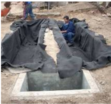
Foto 83 y Foto 84 Instalación de la lámina geotextil no tejida.
