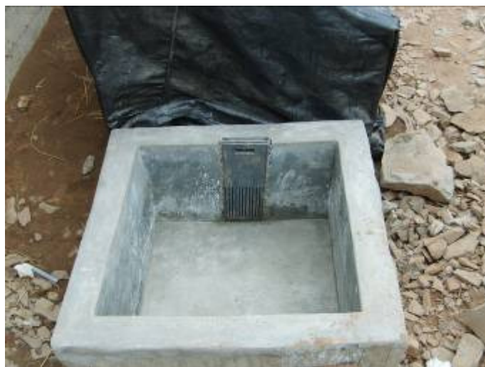
Foto 44 La compuerta de entrada debe ubicarse en la posición central del tanque, justo enfrente del conducto de entrada.
