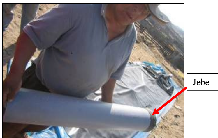
Foto 34– Tubo de entrada con jebe en el extremo que irá dentro de la manga (en la foto se aprecia también la manga encima del plástico)
