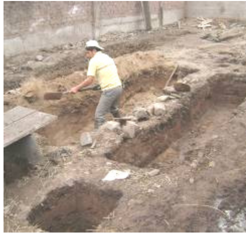
Foto 61 Avance según el diseño y excavación de los humedales.
