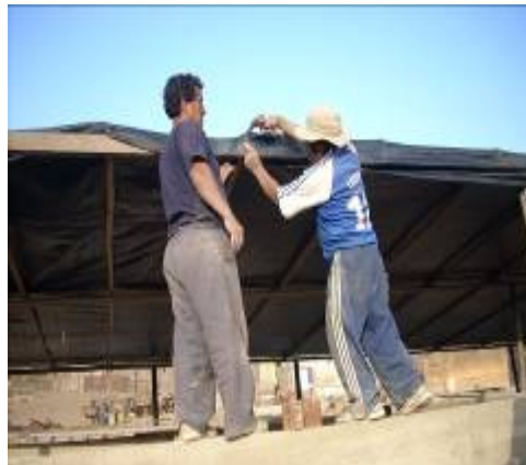
Foto 21, Instalación de arpillera en techos
