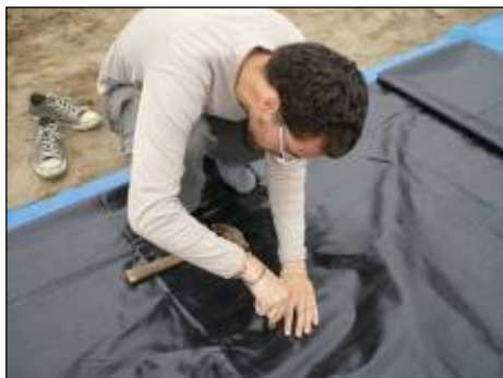
Foto 28 y Foto 29 Perforación de la salida del gas
