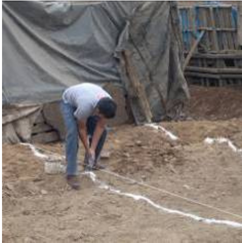
Foto 59 y Foto 60 Trazado con tiza en polvo y estacas.
