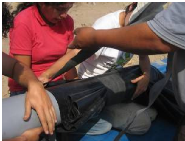
Foto 35 Fijación del tubo de entrada, con la tira de jebe y la manga doblada en acordeón
