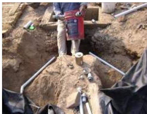
Foto 76 y Foto 77 Ubicación exacta del niple especial en la rampa de ingreso del humedal y empalme con el tanque de repartición de caudal.
