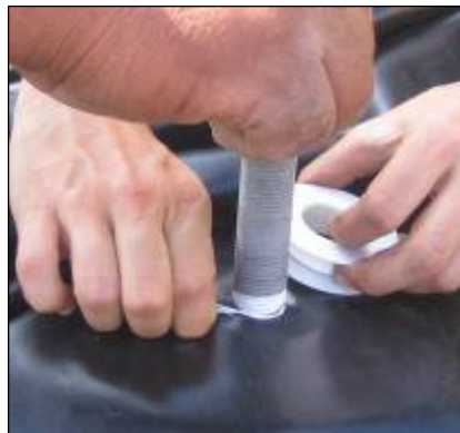
Foto 31 Niple atravesando la manga con el disco de jebe, el de PVC y la contratuerca debajo de la manga
