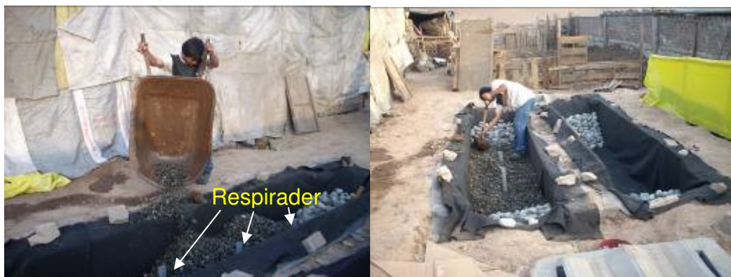
Foto 86 y Foto 87 Transporte con carretilla, disposición del sustrato en el humedal y llenado uniforme en el humedal.
