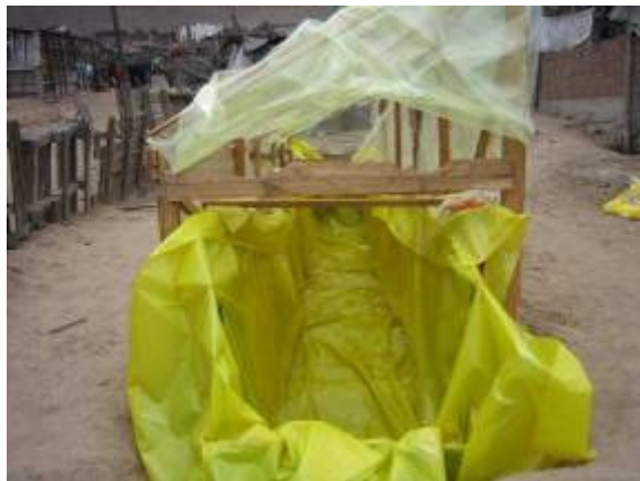
Foto 39 Colocación del plástico (amarillo) por encima de las parihuelas
