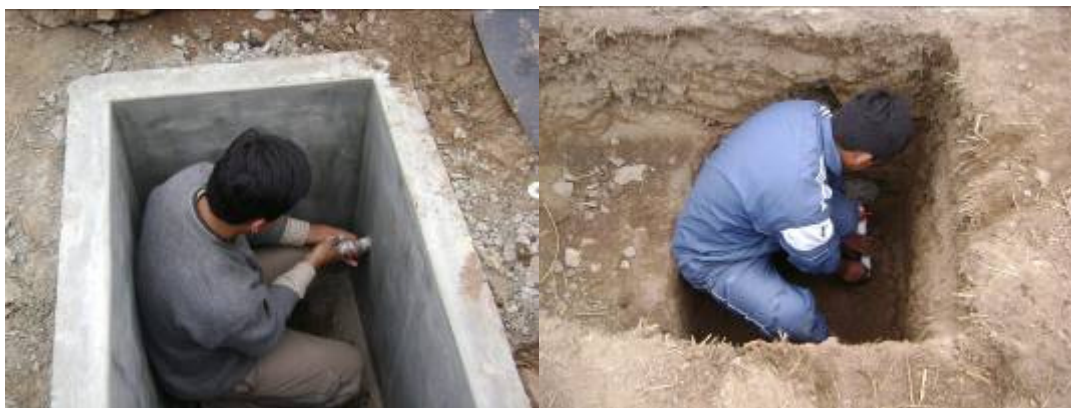
Foto 74 y Foto 75 Colocación de accesorios y colocación de válvula con reducción.
