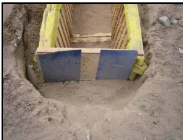
Foto 42 Tabla de contención colocada
