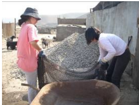
Foto 85 Lavado de grava de ½” en una batea metálica.
