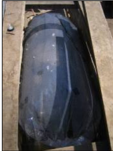
Foto 49 Reservorio de gas
