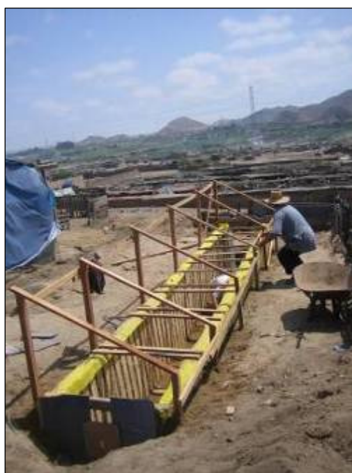
Foto 25 Colocación de columnas y armazón de techo del invernadero
