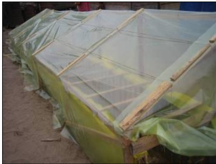
Foto 26 Listones para el clavado del plástico de invernadero
