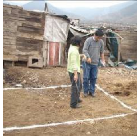
Foto 59 y Foto 60 Trazado con tiza en polvo y estacas.
