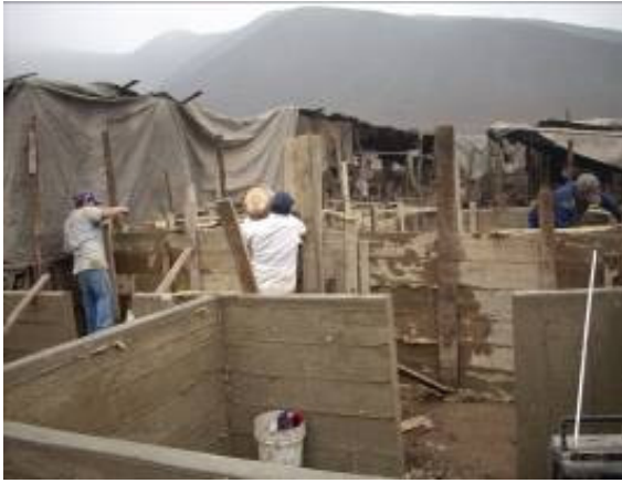
Foto 18, Construcción de corrales
