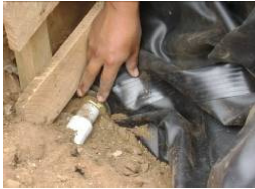
Foto 79 y Foto 80 Detalle de la conexión de salida del humedal. Vista externa e interna del humedal.
