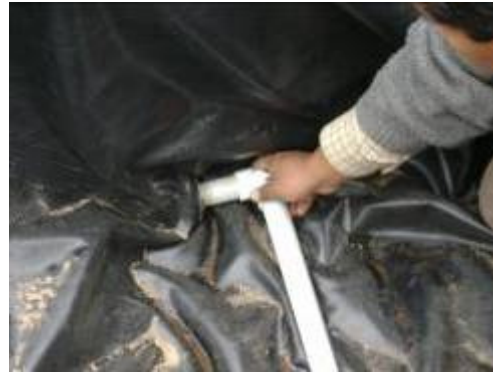
Foto 79 y Foto 80 Detalle de la conexión de salida del humedal. Vista externa e interna del humedal.
