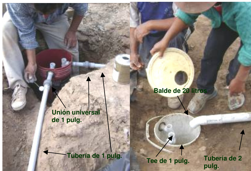
Foto 67 y Foto 68 Colocación de accesorios y tapa del tanque de repartición de caudal.
