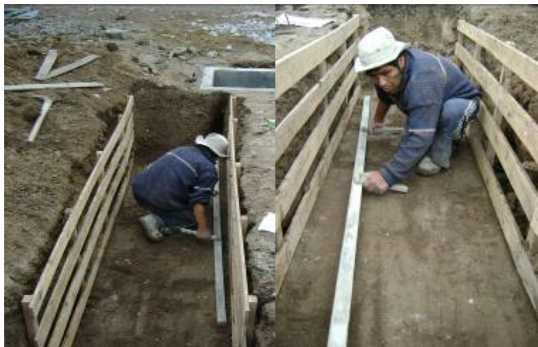
Foto 65 y Foto 66 Compactación y nivelación del fondo del humedal.
