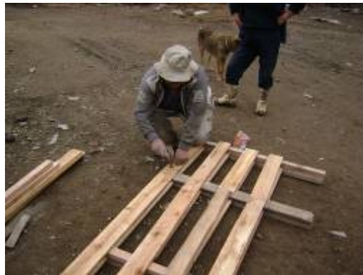
Foto 62 Clavado de listones para refuerzo lateral del humedal.
