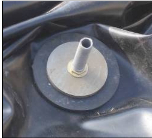
Foto 32 Salida del gas: contratuercas de bronce, disco de PVC y disco de jebe
