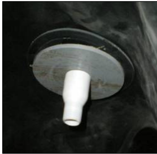
Foto 30 Niple especial en el interior de la manga (pieza de PVC 6 + disco PVC + disco jebe)
