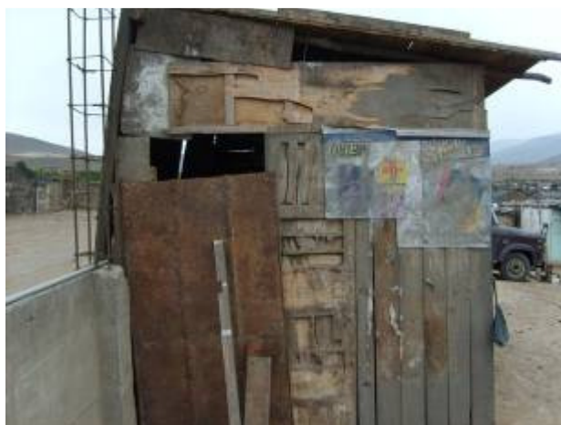
Foto 54 repisa para colocación de reservorio.
