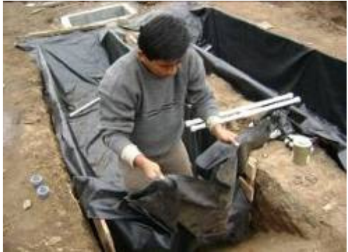
Foto 81 y Foto 82 Instalación de geomembrana de PVC de 0,5 mm.
