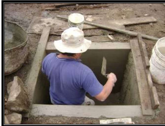
Foto 71 Vista del alisado del tanque.
