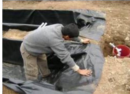
Foto 81 y Foto 82 Instalación de geomembrana de PVC de 0,5 mm.
