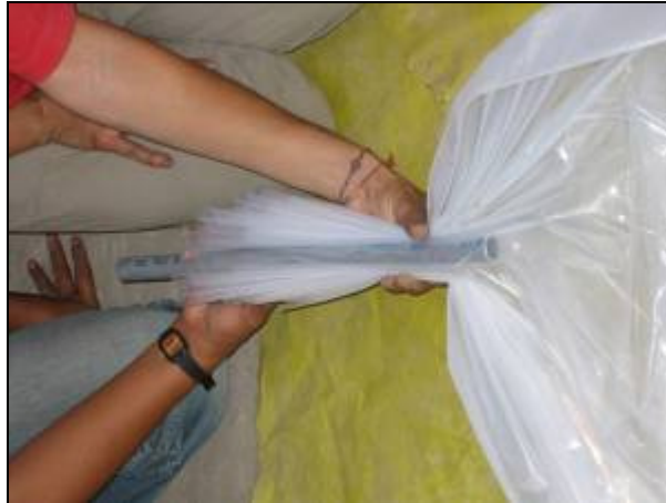
Foto 50 Preparación del reservorio de biogás
