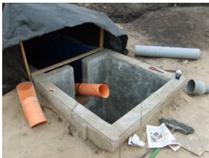
Foto 45 Medición, corte e instalación del conducto de salida
