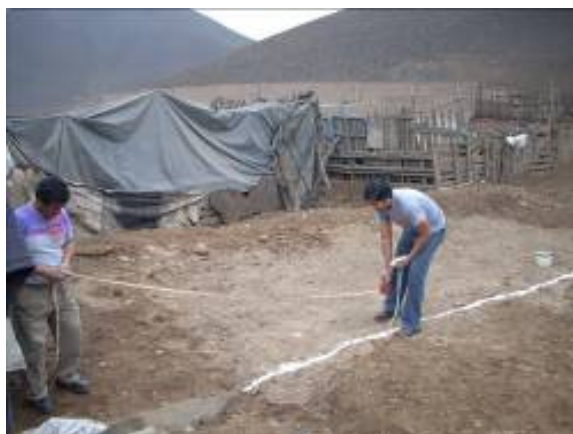
Foto 17 Delineamiento de instalaciones
