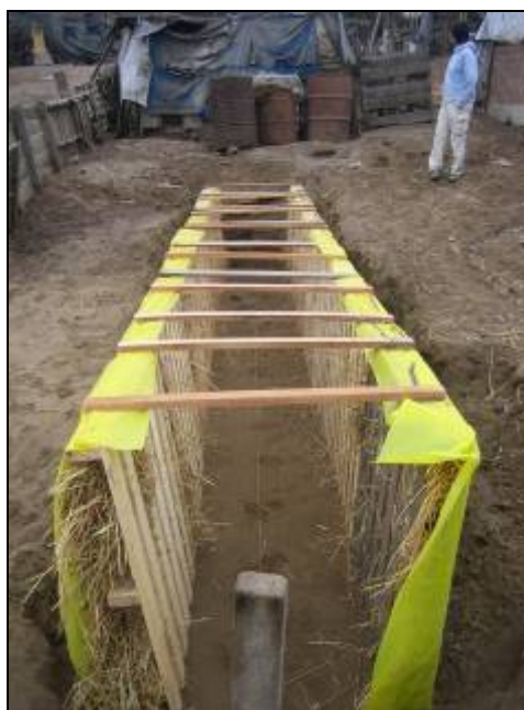
Foto 24 La zanja con las parihuelas colocadas
