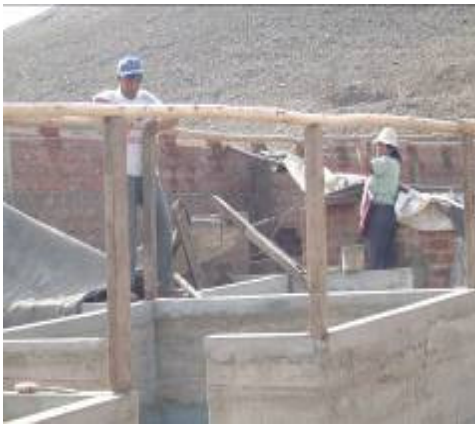
Foto 20, Instalación de armazón de techos
