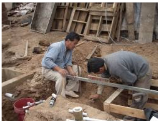
Foto 76 y Foto 77 Ubicación exacta del niple especial en la rampa de ingreso del humedal y empalme con el tanque de repartición de caudal.
