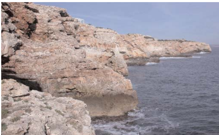
Figura 153. Vista lateral de un conjunto de paleocolapsos que afloran en la costa acantilada de Porto-Colom
