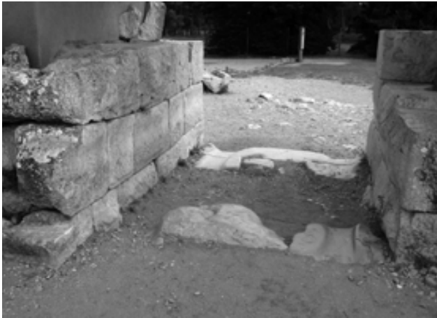
Figura 29. Detall dels desgastos del paviment i els brancals de la porta d'accés nord de la ciutat (N. Romani)
