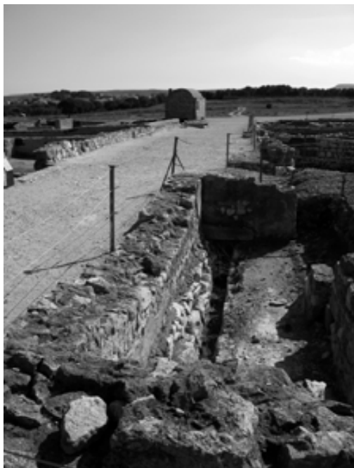
Figura 15. Latrines de les termes que ocupaven part del carrer, amb el col·lector que discorre pel seu subsòl.
